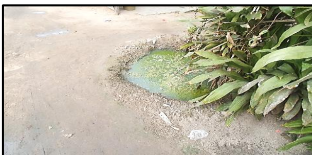
Photo 10 : Trou servant de collecteur dans des eaux usées à Mayanga.
