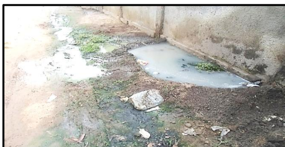
Photo 9: Canal servant d'évacuer les eaux usées de la parcelle vers la rue à Mbouono
