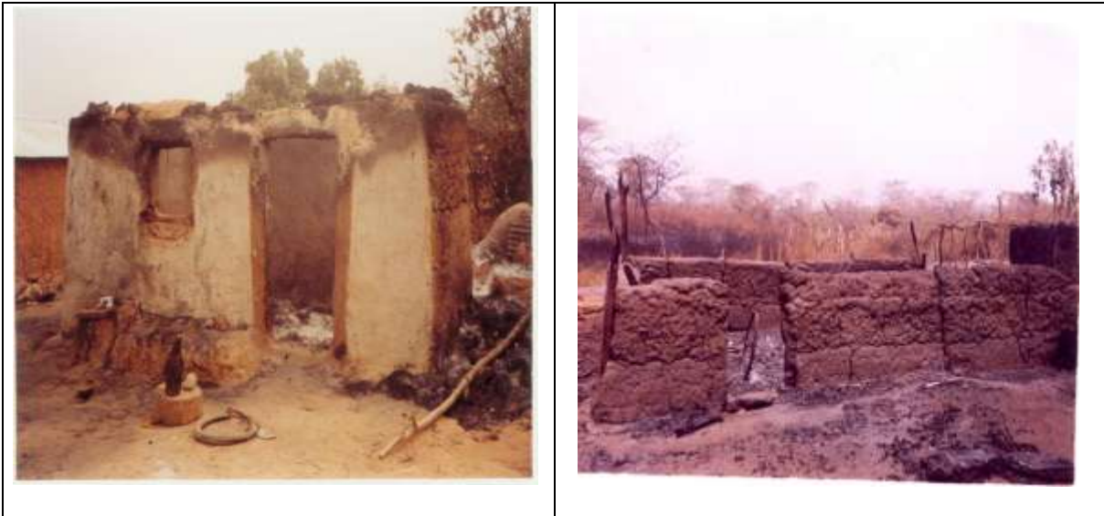
Planche 1 : Incendie d'une case à N'kpotéfé et à Ti-Sonwimè
