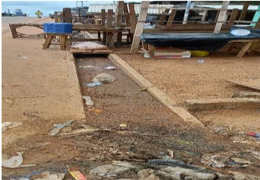
Photo 1 : Caniveau longeant la voie principale au centre-ville (prise de vue : étude de terrain, 2021).
