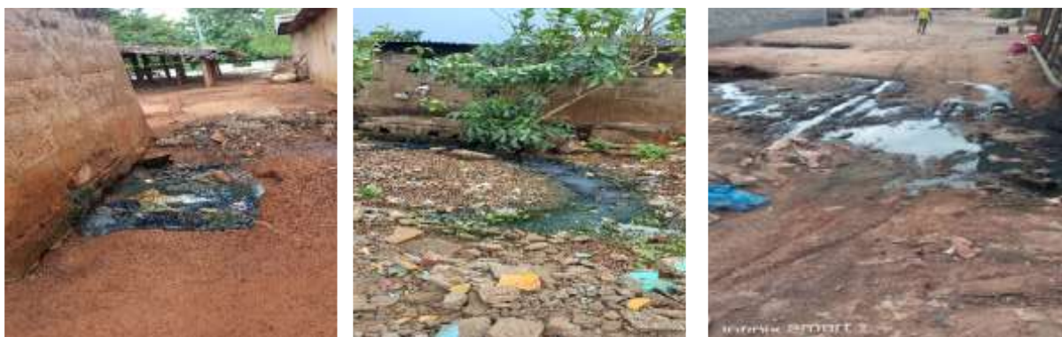
Planche photo 2 : Des eaux usées provenant des douches à fosse septique à ciel ouvert et eau usée déversée en pleine rues dégageant une odeur désagréable (prise de vue : étude de terrain, 2021).
