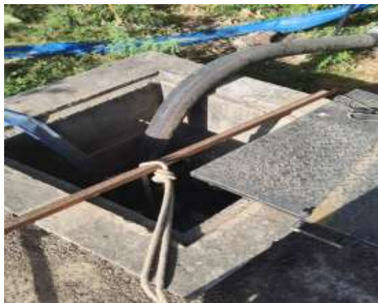
Photo 1 : Ouvrage de relevage provisoire utilisé pour l'évacuation des eaux usées de l'HGRN vers le fleuve Chari
